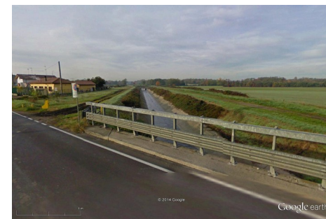
CSNO da ponte via De Gasperi verso valle
